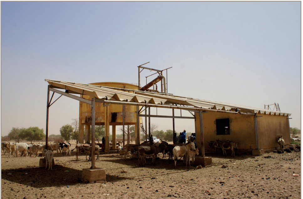
Images 9 et 10 - Pompe solaire thermodynamique Sofretes de Diagle (nord-Sénégal), 3 m 3 /h – 40 m de relevage, en 1977 et en avril 2018
