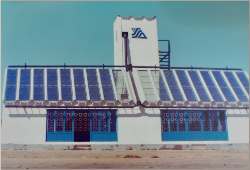
Image 3 - Station de pompage solaire Sofretes de Todos Santos en 1976 (Mexique, Basse Californie, capacité de pompage de 50.000 litres/jour)
