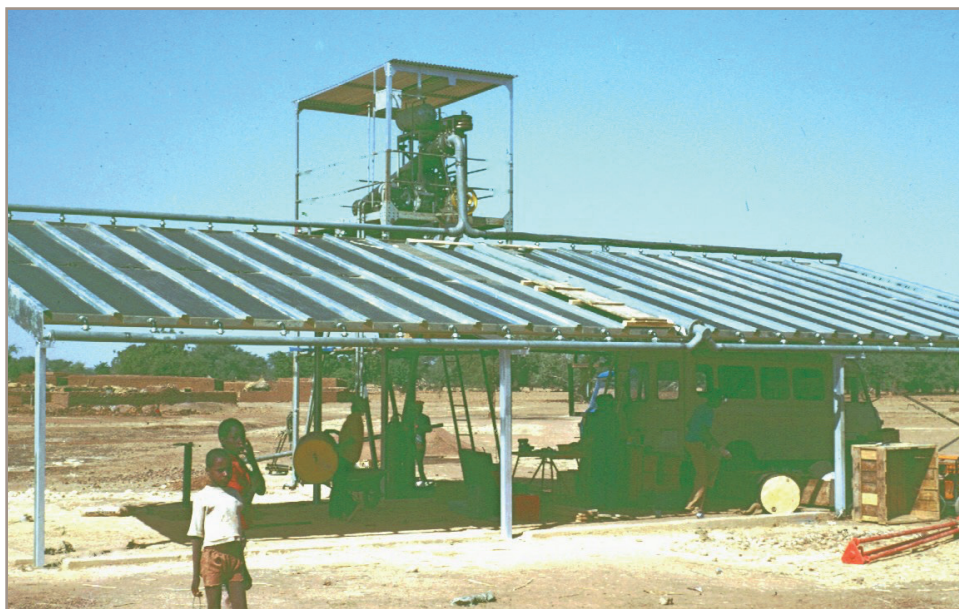
Image 2 - Pompe solaire Sofretes au Burkina-Fasso en 1978
