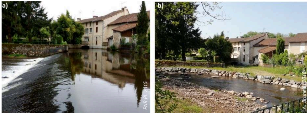
Figure 7 : Site de l'Usine Hydroélectrique de Saint-Pardoux-la-Rivière (Dronne).
