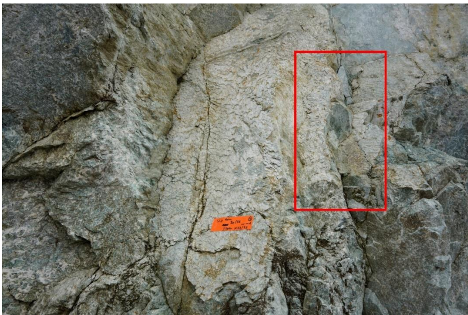
Figure 96 : Zone SF encadrée en rouge à détecter sur l'affleurement rocheux.
